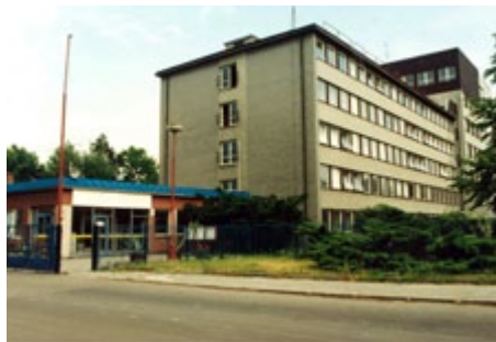
Budova získaná pro OSSZ Nový Jičín před začátkem stavebních prací
