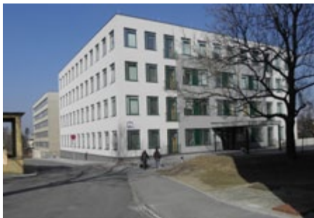
Moderní sídlo opavské OSSZ po dokončení v dubnu 2011
