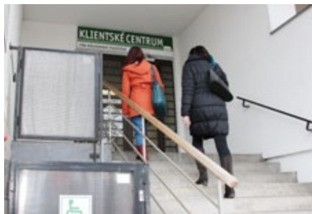
Přístup do pracovišť ČSSZ je řešen bezbariérově – výtahem či nájezdovou rampou
