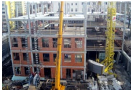
Nová budova OSSZ Opava během výstavby
