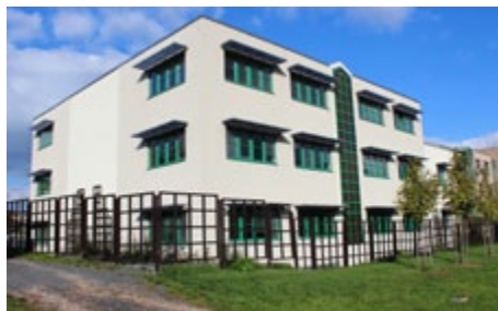
Novostavba archivu ČSSZ v pražských Stodůlkách z roku 2010
